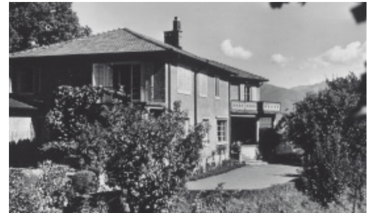
Die Casa Hesse. Bauherr war Hesses Freund Hans C. Bodmer.
